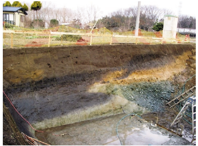
写真2 櫛挽断層用土地区トレンチ西側壁面の様子.
