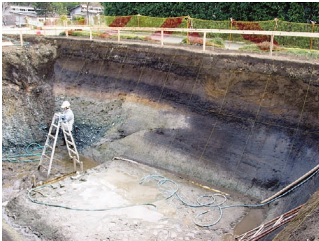
写真1 櫛挽断層用土地区トレンチ東側壁面の様子.
