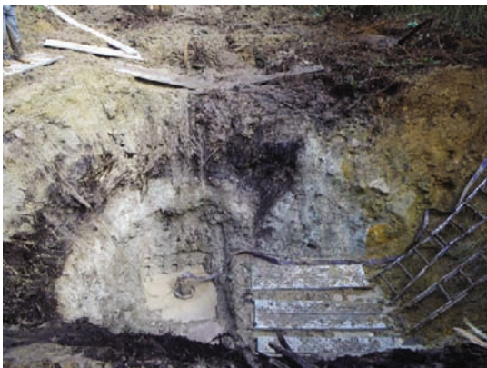
トレンチ北東側壁面。
