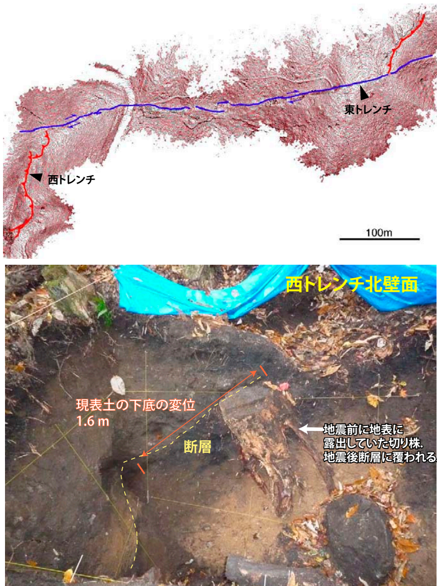
図6 荒砥沢ダム北方トレンチ。(上)位置図。青線と赤線はそれぞれ横ずれおよび逆断層区間における地震断層トレース。(下)西トレンチ北側壁面。
