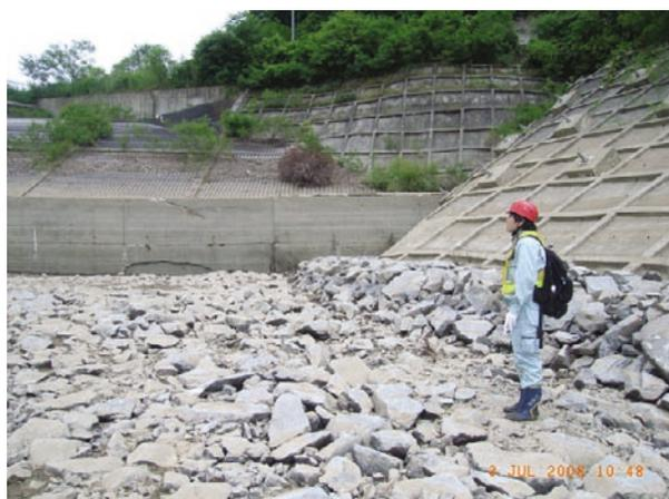
写真12 ダム洪水吐付近の擁壁に圧壊痕がみられる。なお、人物後方の敷石の膨らみは施工時のもの。（南向き撮影）
