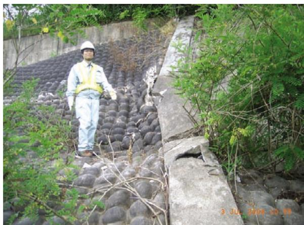
写真11 ダム側壁覆工の変形。人物の足下付近を境に上側の地盤が下側に乗り上げ、左側に動いている（南向き撮影）。
