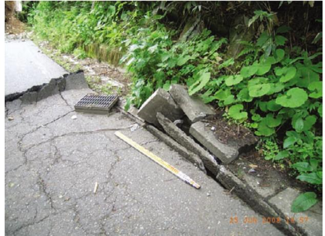
写真7 行者滝の西方にて短縮変形を示すアスファルト舗装と側溝の重なり(南東向き撮影)。
