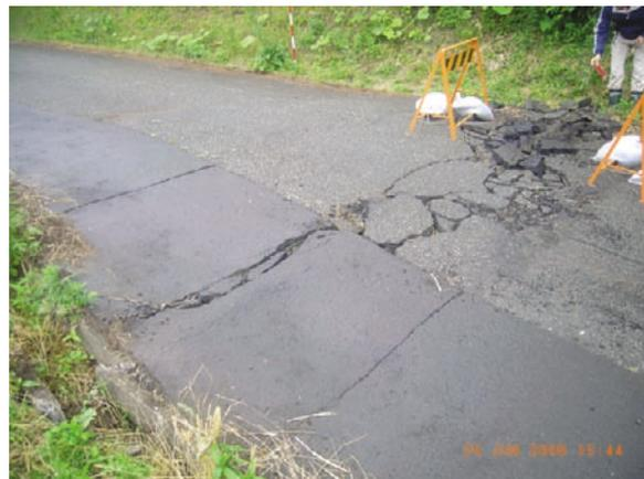
写真4 岡山地区の舗装道路の短縮変形（図6地点Aより北西向き撮影）。アスファルトや側溝が重なっている。
