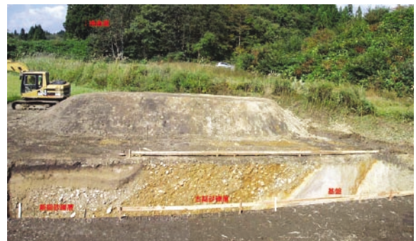
写真1 H-2 トレンチ壁面と撓曲崖。
