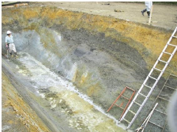
トレンチの南東側壁面。
