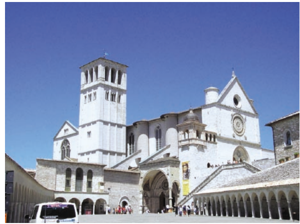
写真3. 地震による損壊から復旧したアッシジのサンフランチェスコ聖堂。
