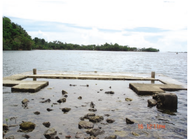
写真3 船着き場が沈降した様子 (Lengana, Simbo 島).
