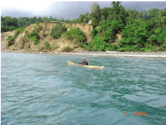
写真4 地震により土砂崩壊した様子 (Mondo, Ranongga 島).
