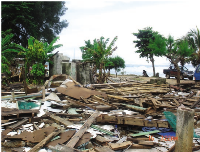
写真1 津波による被害の様子 (Malakerava 3丁目, Gizo島)。
