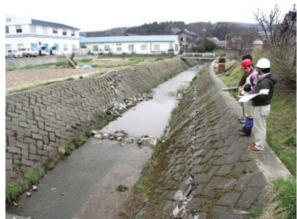
写真4 道下地区の護摩堂川の護岸に見られた圧縮性が卓越する変状。図2の地点2。南方を見る。
