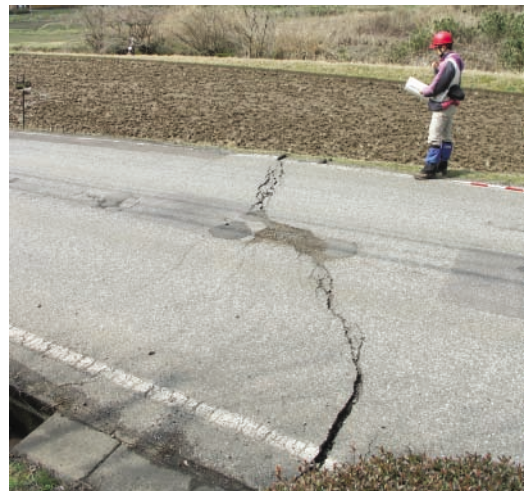
写真3 中野屋地区において県道を横切る地震断層。図2の地点1。南西方向を見る。
