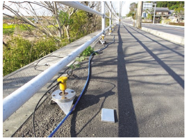
写真3 道路部における地震計の設置状況。大野川測線の南側 3km ほどは道路区間となっている。なお、ノイズを減らすため、1つの地震計は9個のセンサ群で構成されている。
