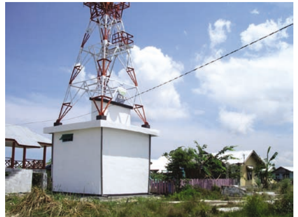
インドネシア気象庁（BMG）によって立てられた津波警報を知らせるサイレン（まだ機能していない）。右側には津波で流された家の土台が、後ろには新たに建てられた家が見える。
