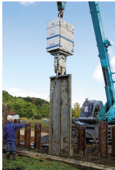
写真1 ジオスライサーの群列掘削。
