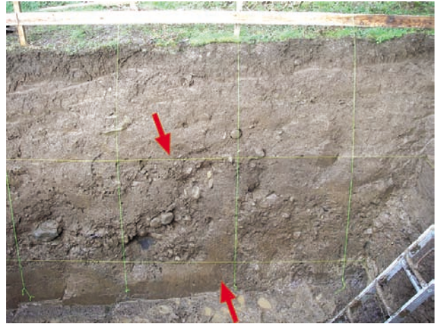
東側のトレンチの東側壁面(矢印の間が断層)
