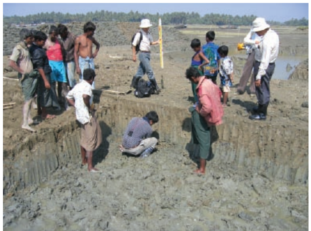
写真2 干潟での道路建設現場。手前が建材（泥塊）を採取した穴で、後が建設中の道。すべて人力で行っている。
