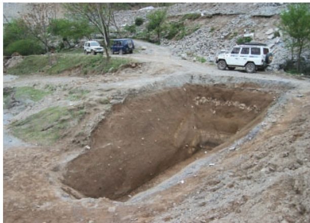
写真2 ムザファラバード北方で行われたパキスタン初のトレンチ調査。
