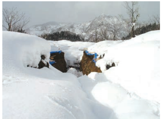
雪ですっかり覆われてしまったトレンチ
