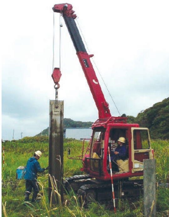
ジオスライサーによる掘削調査の様子。
