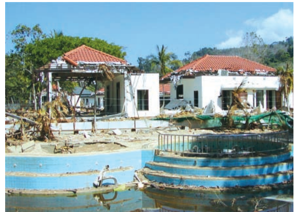
図2 津波で破壊されたカオラックリゾートホテル
