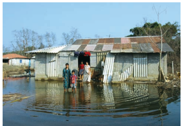
写真 1 地盤の沈降による浸水被害を受けた家屋
