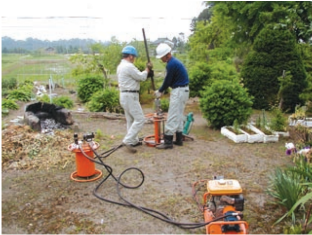
ボーリング掘削状況
