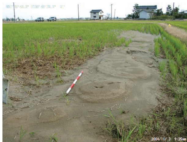
写真6 液状化による噴砂。信濃川沿いの水田に多く見受けられた。（長岡市岩野地区）
