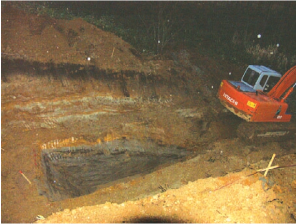
蕨岱トレンチの掘削状況（11月12日現在） 知来川層（後期更新世に堆積した腐植質シルト層と砂礫層からなる互層）が断層付近で撓曲変形している。
