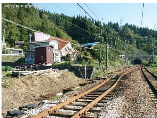
写真5 変形した線路と倒壊した家屋。（川口町川口）
