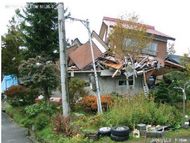
写真4 倒壊した家屋。田麦山地区の扇状地性段丘上では、ほとんどの家屋が震動による大被害を受けていた。（川口町田麦山地区）
