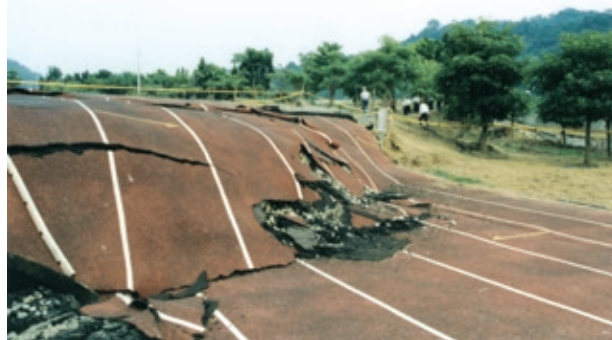
1999年台湾集集地震で生じた地盤の変形
