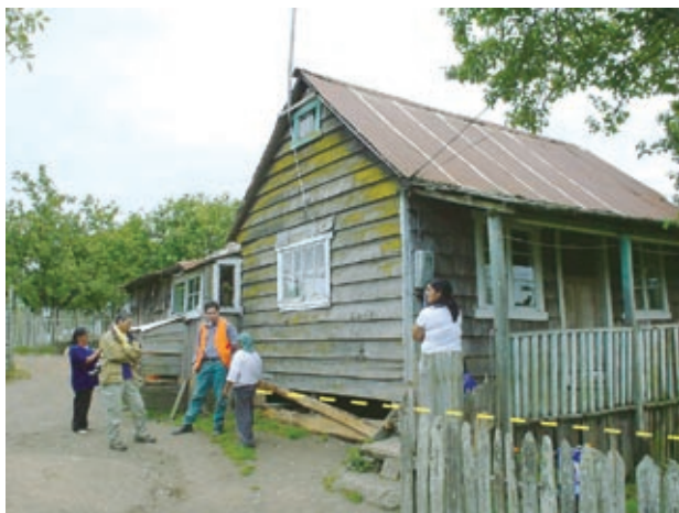
写真1 チャミザのピラーハウス。黄色の点線が地震前の最高潮位レベル
