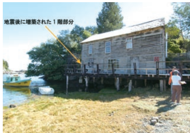
写真2 メトリのピラーハウス。1階部分は地震隆起で生じた隙間に増築された。
