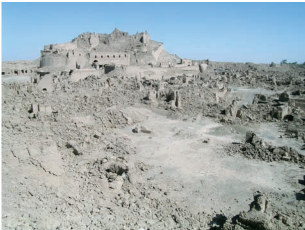
写真1 地震で崩壊したアルゲ・バム城塞 (吾妻撮影)
