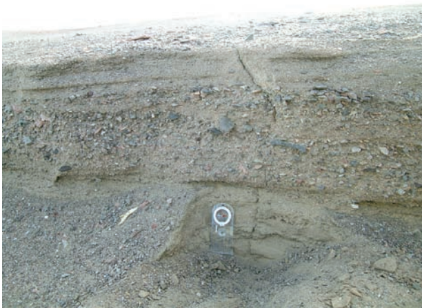
写真6 開口亀裂の断面（北部セグメント：吾妻撮影）
