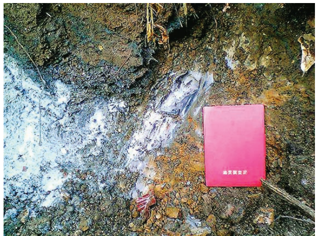
写真2 馬神山西方で確認した津軽断層の破碎帯。鮮新統の乳白色火砕流堆積物とそれが破碎された青白色の断層粘土の境界が確認された。両層の境界の走向・傾斜はN43E, 69Wを示す。破碎帯の断層粘土は破碎が進み、非常に柔らかい。断層粘土よりも西側（上盤側）には、中新統の黒色硬質泥岩が分布する。
