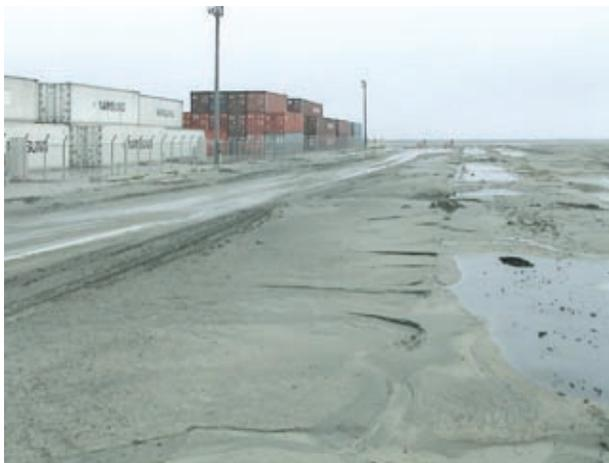
釧路西港第4埠頭で発生した液状化現象。車道と歩道との境界付近から砂が噴出し、車道をほぼ埋めている。
