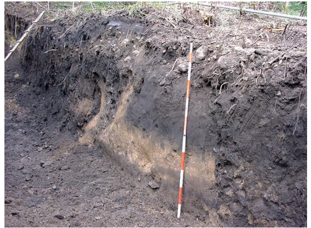
トレンチ掘削作業中、北側法面に出現した断層
