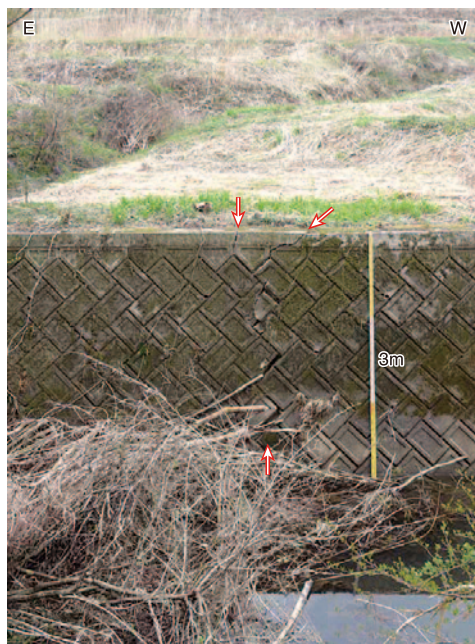
第11図 遠野町釜ノ沢を流れる天ノ川右岸側護岸擁壁の変位（矢印で示す）。南に向かって撮影。2012年4月28日撮影。
