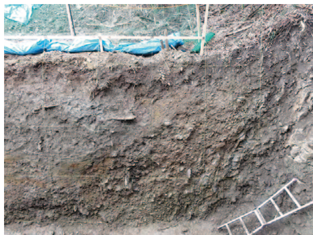
第13図 釜ノ沢地区トレンチ北壁面の写真。グリッド間隔は1 m。
