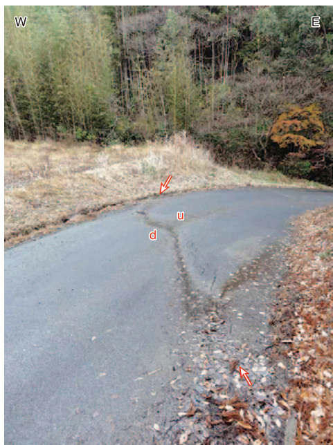
第10図 田人町佐倉地区でみられた井戸沢断層東トレース沿いでみられたアスファルト道路を切断する地表変位（矢印で示す）。北に向かって撮影。2011年12月16日撮影。
