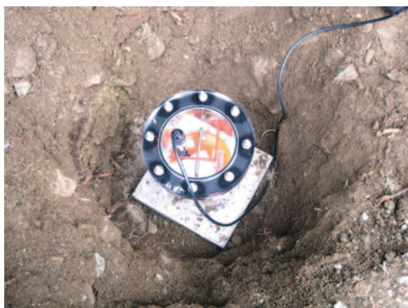
写真 1 地震計の埋設。地震計を地中に埋めるために高さ 50cm、幅 50cm 程度の穴を掘った。穴の底には厚さ 5cm のコンクリート板を敷き、その上に置いた地震計を石膏で固定した。穴の隙間には砂や土を入れた。
