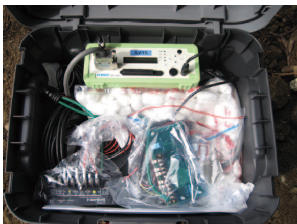
写真 2 収録装置を格納したケースの内部。ロガー、バッテリー、ソーラーパネル充電コントローラーなどが入っている。
