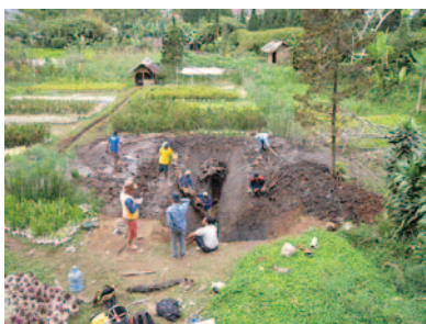
人力によるトレンチ掘削状況。
