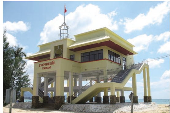
写真6 Pakarang 岬に完成した津波避難施設, 2009年12月撮影。
