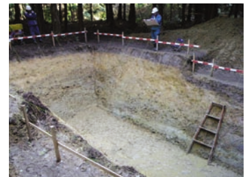
トレンチの南東壁面。
