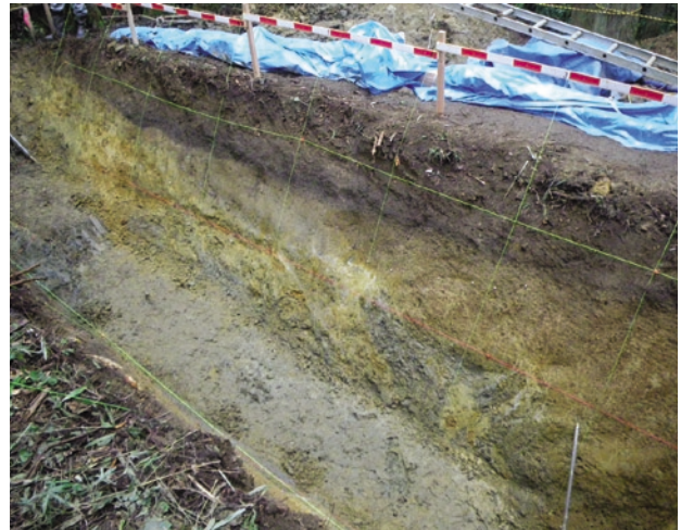
写真2 上林川断層、下八田トレンチの西側壁面。
