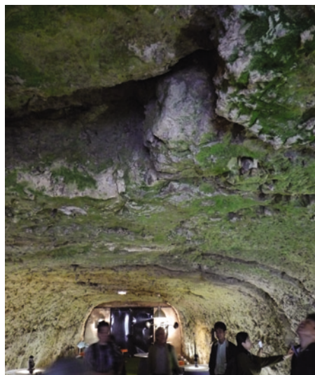
写真5 ワイン貯蔵庫の岩盤。クラックが多数。
