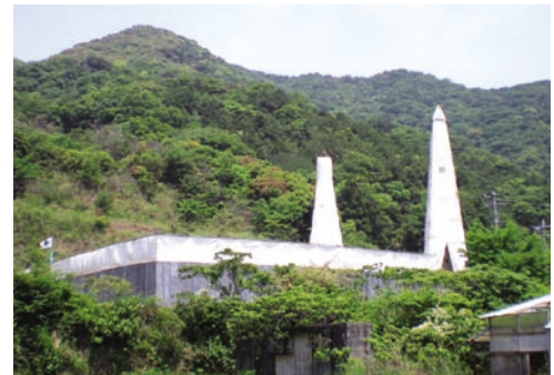
写真1 建設中の地下水等総合観測施設。同観測施設では1箇所について3本の観測井戸が作られる（小泉，2009）。現在、そのうちの2本が掘削されていて、掘削のための2本の櫓には白い防音シートが被せられている。現場の周囲も防音壁で囲われている。
