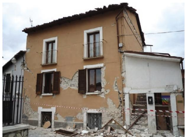
写真2 組積造建物の被害。壁に大クラック。L' Aquila 旧市街 (11 April 2009 撮影)。
