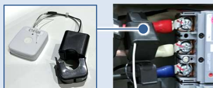
無線式電流センサ 配電盤 安価・簡便なシステムで多設備を同時計測
