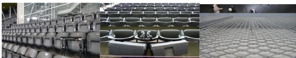
図 4.2.2-7：ネット裏に設置した内野席音響シート。右は外野席に設置した集音マイク
