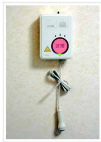
図 4.3-7 : ナースコール設備
