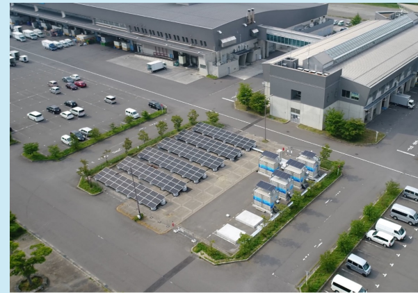
図1：Hydro Q-BiC実証サイト@郡山市総合地方卸売市場
