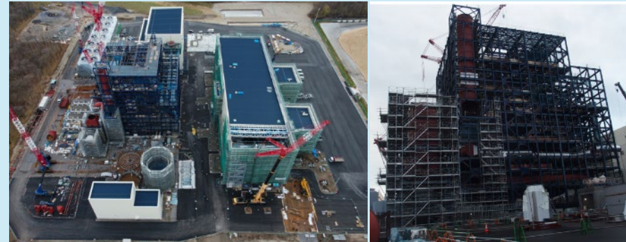
図1：調査対象モデルとなるバイオマス発電所の建設状況
