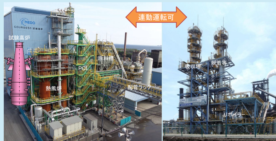
図1. COURSE50 試験高炉(34トン溶銑/日) 図2. CO 2 分離回収設備(30トン-CO 2 /日)
