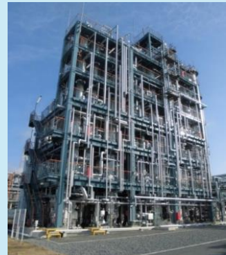
図2：実証プラント（旭化成水島製造所）
