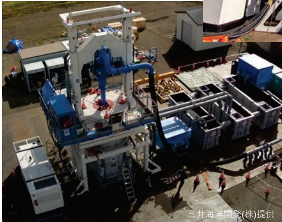
掘削試験設備全景
