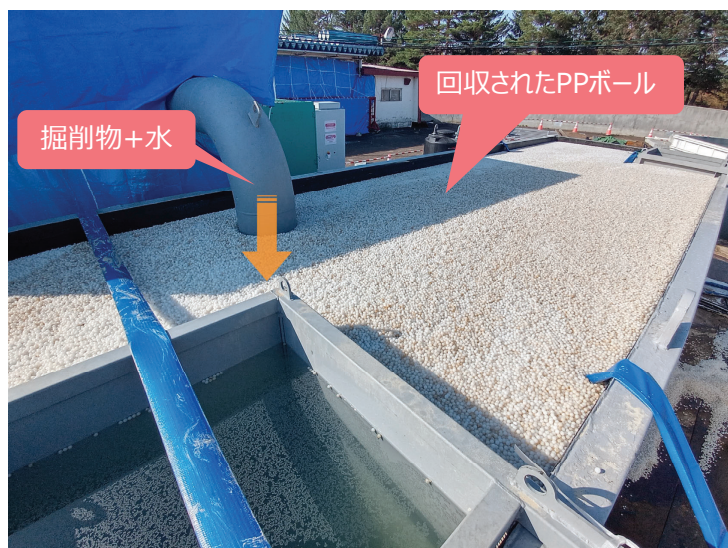
掘削後の24m 3 水槽
