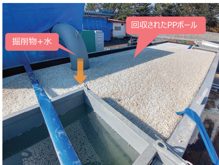
掘削後の24m 3 水槽
