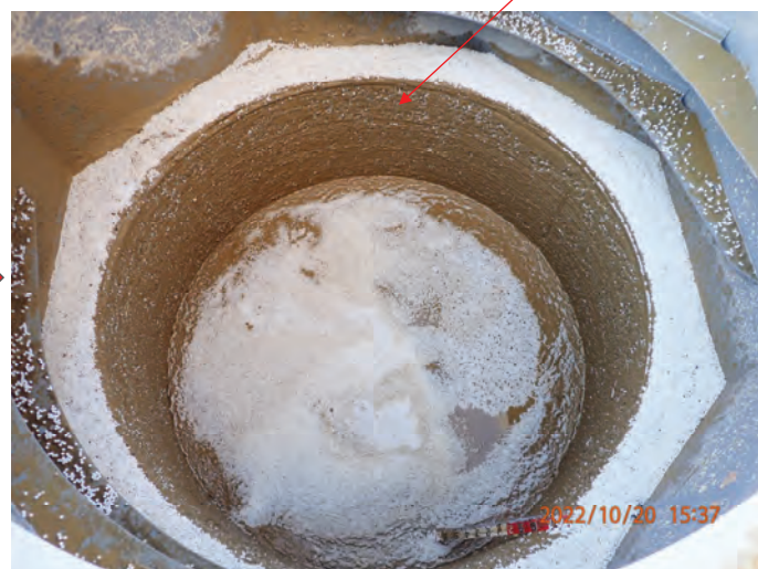
掘削後（タンク内）
