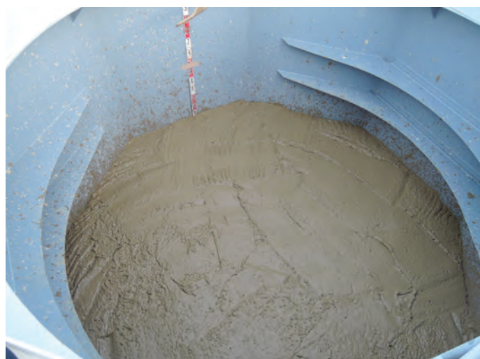
掘削前（タンク内）
