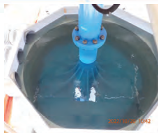
掘削中の様子
