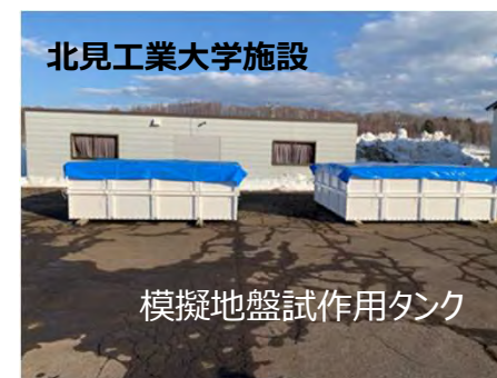
模擬地盤による掘削試験 (20%MH)
