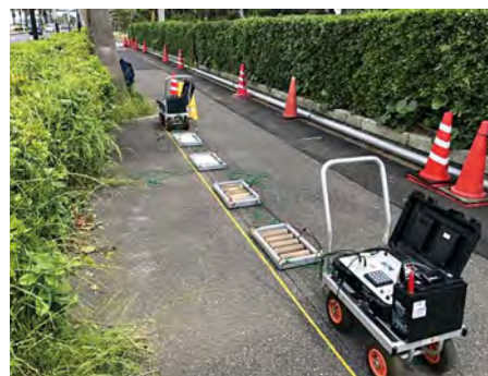
開発した電気探査測定装置による測定状況
