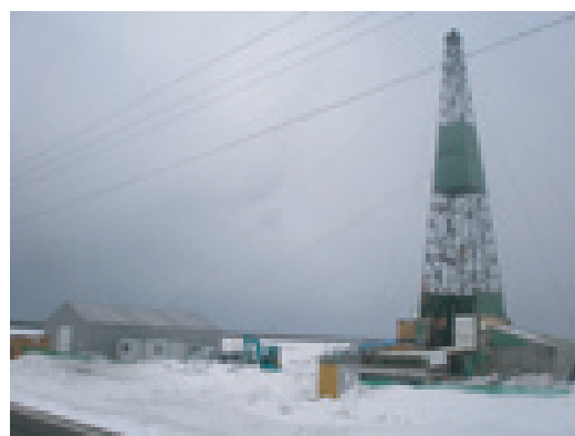
厳冬の掘削現場写真
