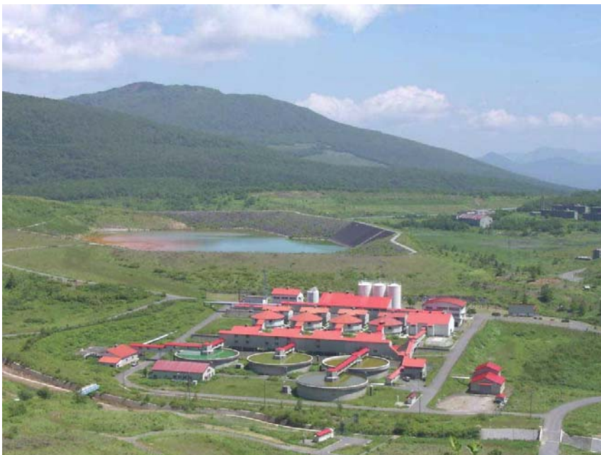
第 3.5 図 松尾鉱山の坑廃水中和処理施設
