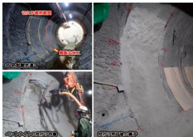
図12 坑道側壁部におけるベントナイト吹付け試験の状況(資源エネルギー庁 Web サイト<sup>16)</sup>より転載)
