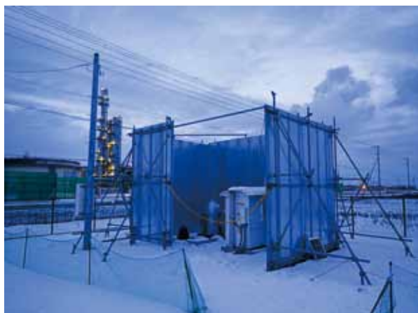
図2 苫小牧における産総研の重力観測基点 背景の照明付き塔は実証試験 CO 2 分離回収設備。
