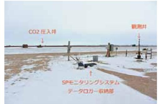
米国大規模 CO<sub>2</sub>圧入テストサイトにおける SP モニタリング
