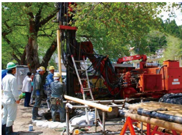
被災地におけるボーリング調査の様子
