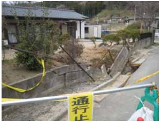
図2. 出水によって陥没が生じた道路(4月8日撮影)
