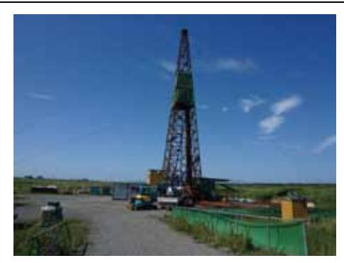
図3 沿岸域での深部（1000m）地下水調査の様子：北海道幌延町での掘削。深部地下水の流动や環境を評価している。好天時には利尻島が見える
