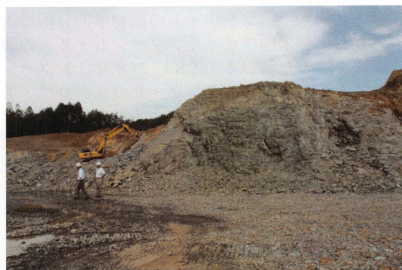
図7 愛知珪石(愛知県犬山市)の採石場。花崗岩による熱変成作用を受けた層状チャートで、建材用珪石として利用されている。
